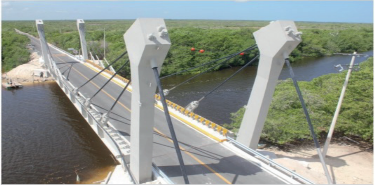
Puente Las Coloradas
