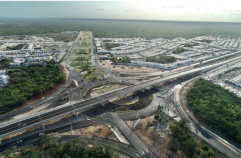
Construcción de paso superior vehicular Avenida 70 km 1+000 de la carretera Mérida-Tetiz /Hunucmá.
