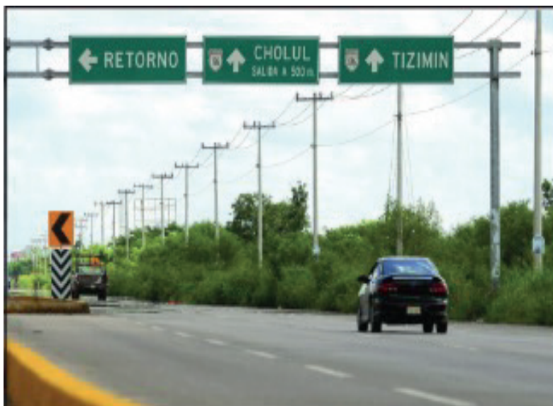
Modernización y ampliación de carretera de 7 a 12 mts. de corona con terracerías, pavimentos, obras de drenaje, obras complementarias, señalamiento vertical y horizontal.
