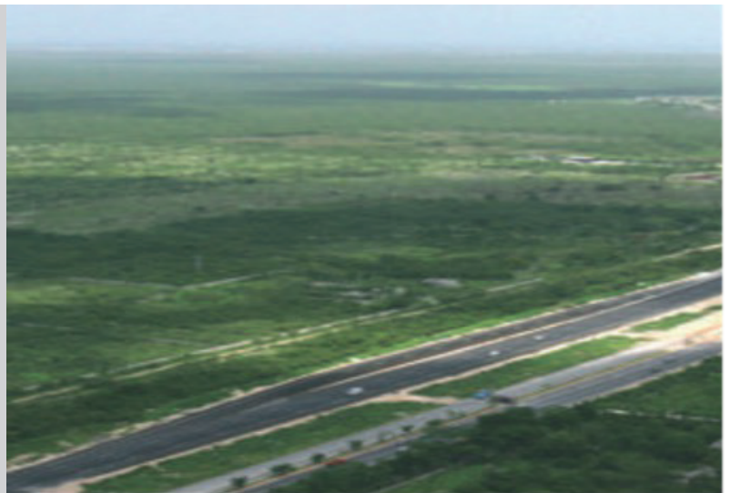
Carretera Mérida - Progreso. Edo. Yucatán.
