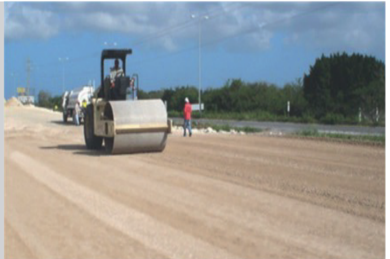
Carretera Mérida - Progreso Edo de Yucatán.
