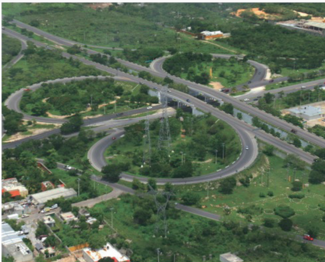
Distribuidor vial entronque Anillo Periférico Mérida – Progreso.
