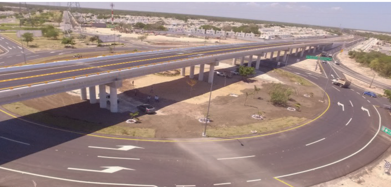
Construcción de paso superior vehicular avenida 70 Km.
