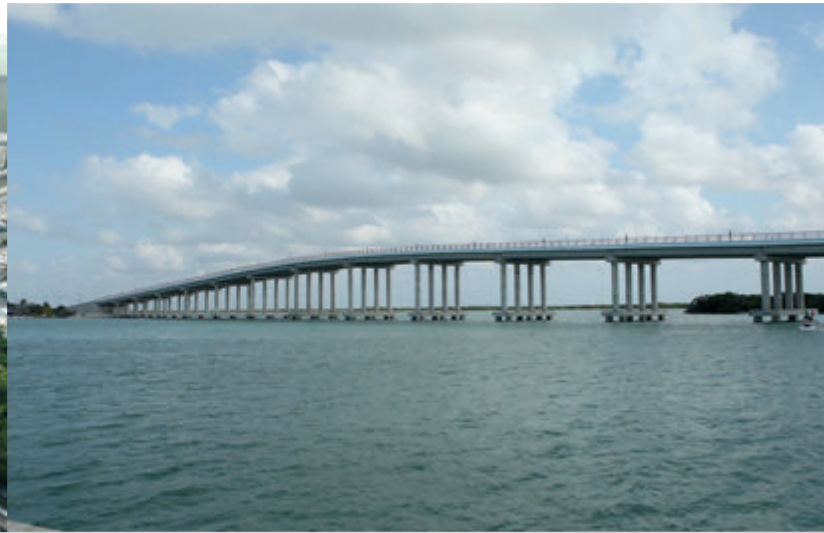
Puente Yucalpeten km 4 + 020 Mérida - Progreso ramal Yucalpetén. Trabajos de terracería y pavimentos puente Yucalpetén.
