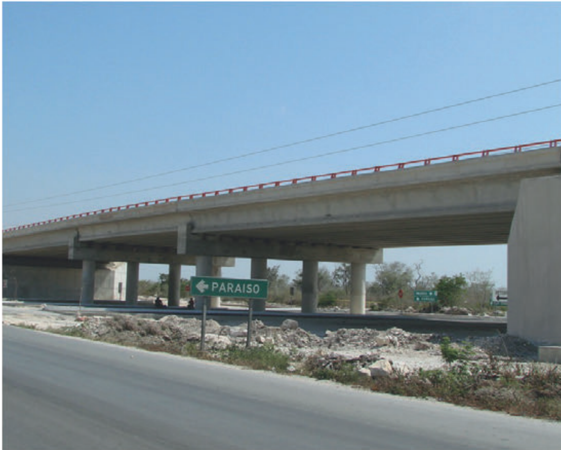
Paso a desnivel puente Paraíso, Mérida - Progreso
