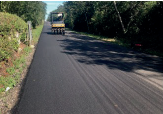
Trabajos de conservación en la carretera: Valladolid - Felipe Carrillo Puerto, Tramo.
